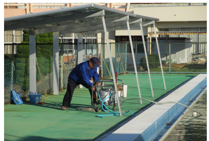
浄水器設置と試運転
